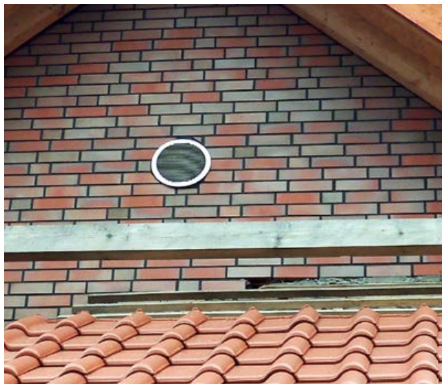
Czerpnia / wyrzutnia w budynkach z wentylacją mechaniczną
