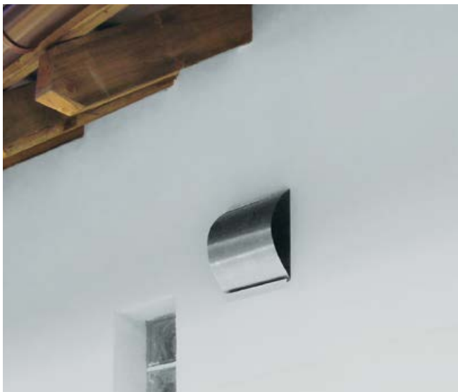
Czerpnia / wyrzutnia w budynkach z wentylacją mechaniczną
